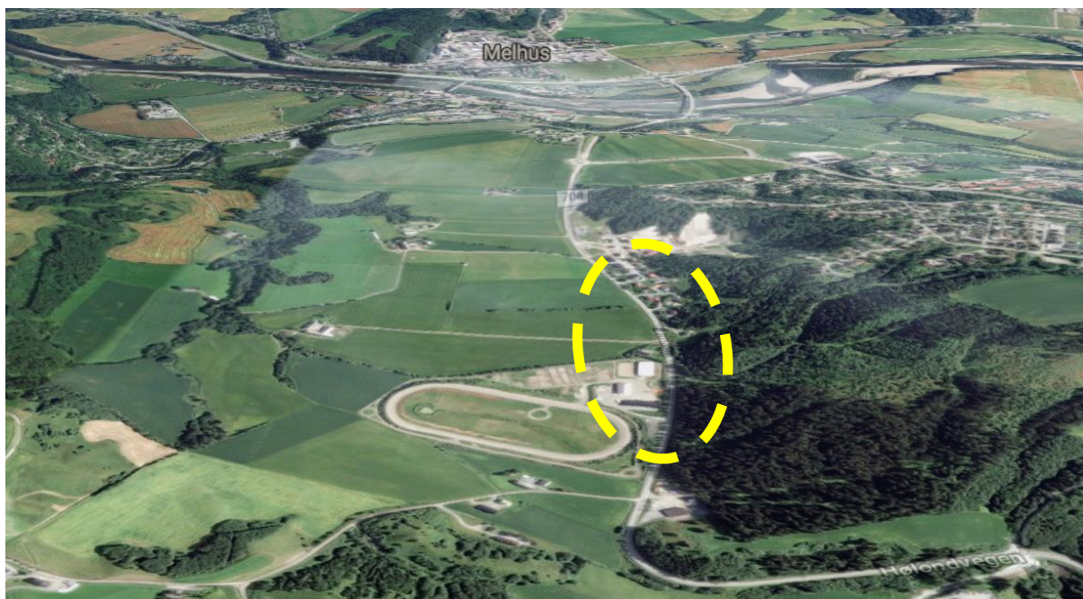
Figur 2-2 Oversiktsbilde sett østover med omtrentlig utstrekning av planområdet (Kilde: Google Maps 3D)
