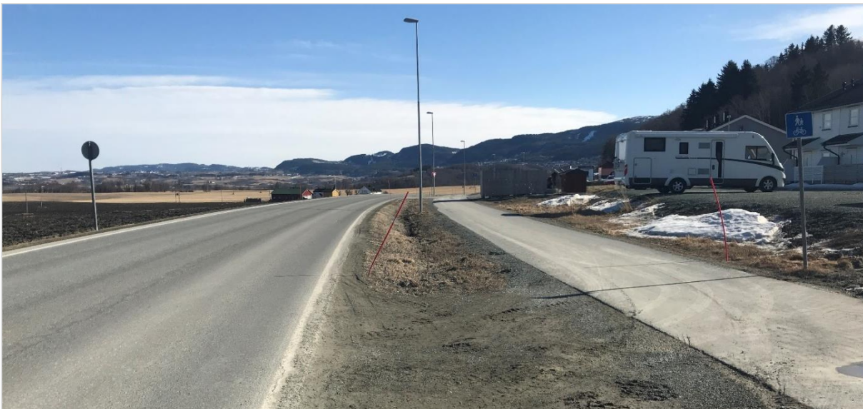
Figur 2-6 Eksisterende gang- og sykkelveg ved Vollmarka sett østover mot Melhus sentrum (2018)
